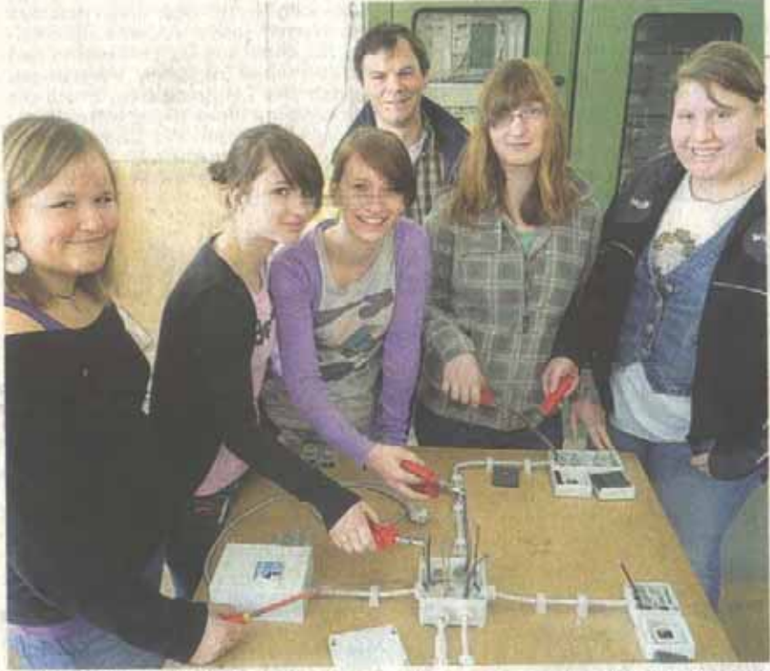
Beim Zweckverband Reckenberggruppe interessierten sich die Mädchen für das Verteilernetz und die damit zusammenhängenden technischen Einrichtungen.
