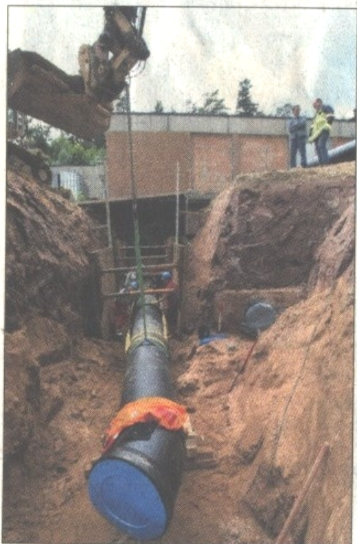
Ohne Störungen wurde jetzt auch die Zu- und Ableitung zum Hochbehälter erneuert und in das Leitungssystem eingebunden.
