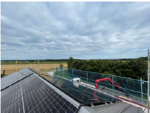
Installation der 2 Anlage auf dem Dach des Pumpwerks Wolframs-Eschenbach Juli 2024; Kosten ca. 31.383 EUR
