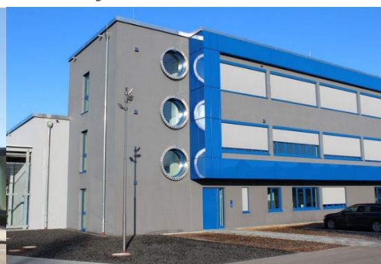
Neues Lager- und Verwaltungsgebäude Wassermungenau (BA II)
