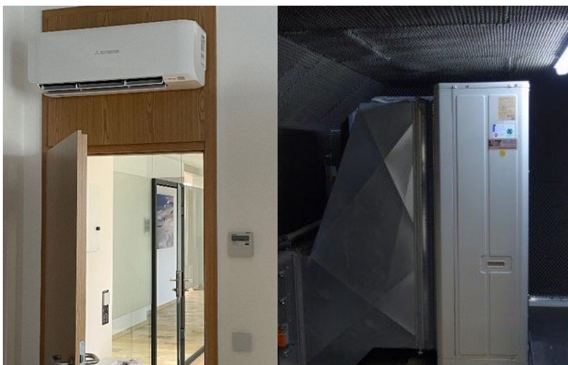
Außengerät Mitsubishi FDC335KXE6 Raum-Innengerät Mitsubishi FDK22KXZE1
