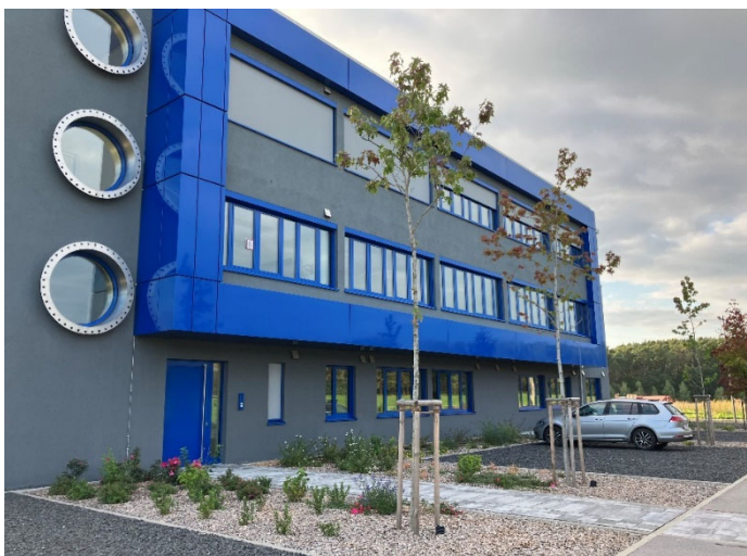
Neu angelegte Strauch- und Baumbepflanzung vor dem BA II
