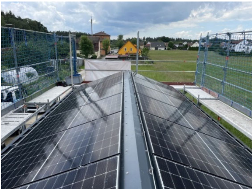
Installation der 1 Anlage auf dem Dach des Pumpwerks Wicklesgreuth Juni 2024; Kosten ca. 6.674 EUR
