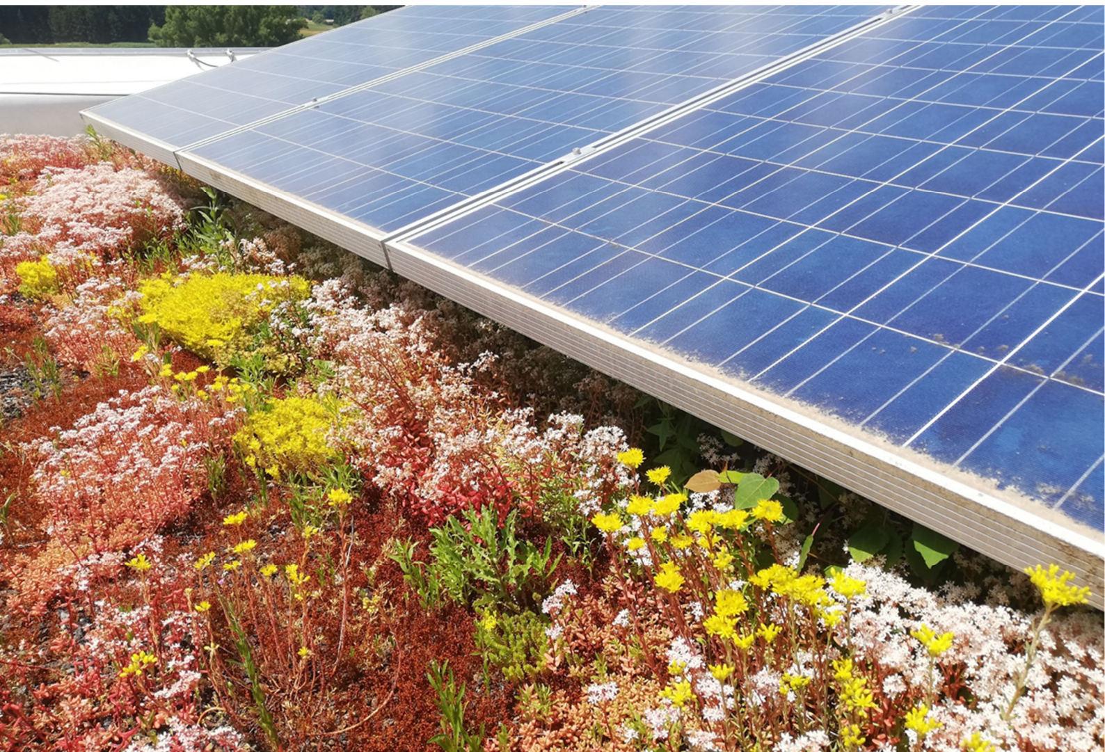
Solar-Grün-Regenwasserretentionsdach am Standort Wassermungenau
